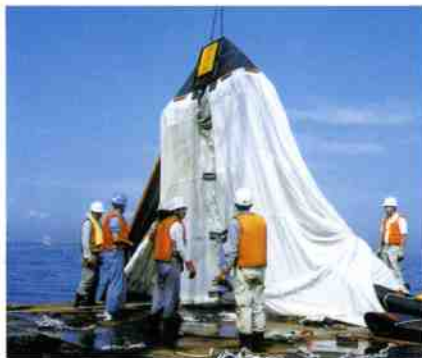
■海上接続作業
