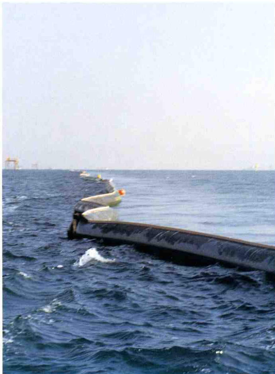
■稼動中の浮沈式マッドバリア
